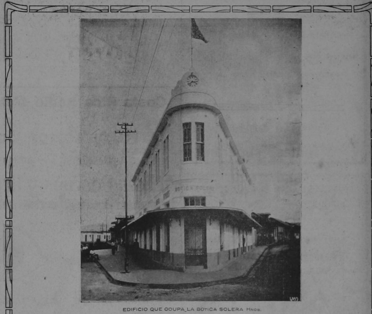
EDIFICIO QUE OCUPA LA BOTICA SOLERA HMOB.
